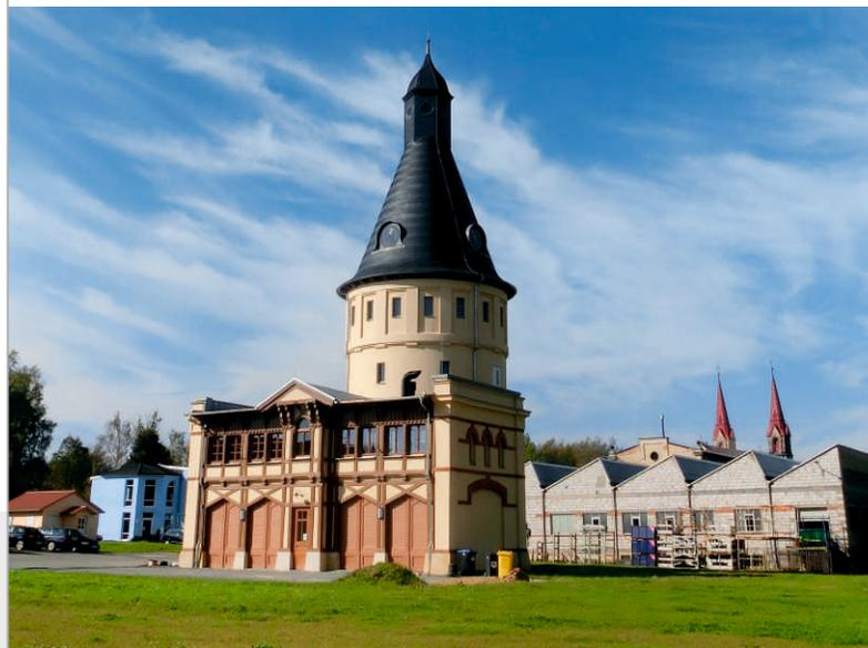
Zur Sicherung des Wasserbedarfs und als Löschwasserreserve erweiterte man das betriebseigene Feuerwehrgerätehaus in 1920/21 um einen konstruktiv modernen Stahlbetonwasserturm. Als Zeugnis des Industriestandorts der ehemaligen Buntweberei und Färberei C. G. Hoffmann und aufgrund der einzigartigen Gestaltung ist das Areal bau- und technikgeschichtlich interessant.
